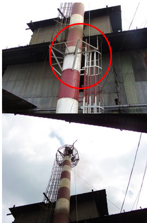
Gambar 7. Penampang bordes dan tangga yang keropos (BBTPPI, 2013)
